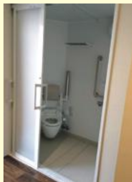
個室病床設備の一部（トイレとユニットシャワー）注) 写真はA個室です。
