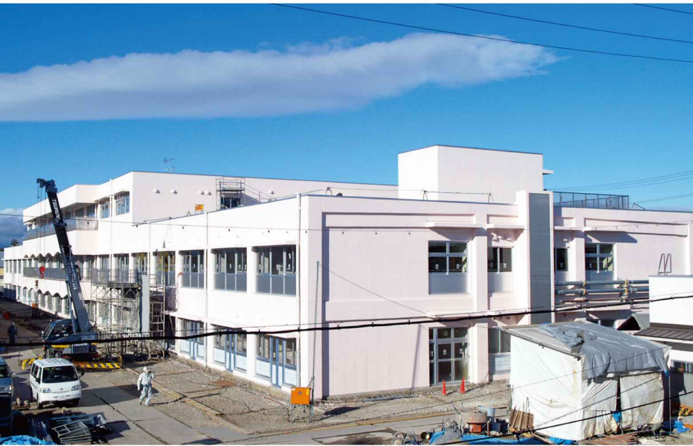
完成間近の中央病棟
