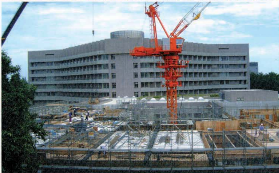
着々と進む建設工事
