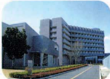
新病棟の全景(この右側には外来棟などがあり、現在工事中)
