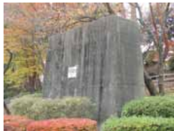
大きなコンクリートの塊（橋脚1）
