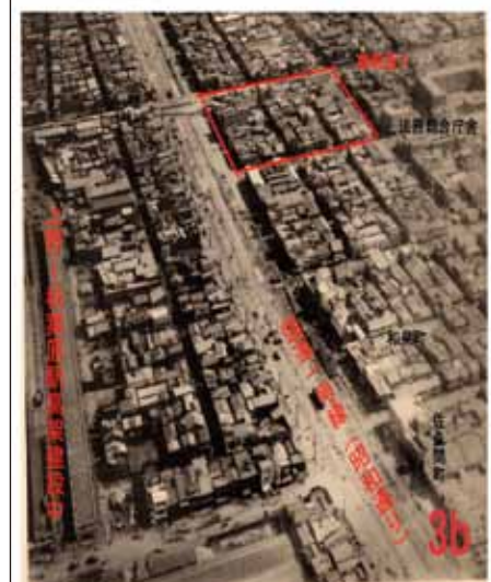
図3a;関東大震災後に復興局中心に作製された「帝都復興区画整理誌」の第31地区換地位置決定図です。本文参照。図3b;昭和5年に空撮された復興した家並みの写真で、和泉橋から国道一号線沿い上野方面を望みます。ここでは蔵前通りが27m幅に改修され、昭和通りが44mに拡幅されて、いまだ工事中の様子が見てとれます。法務省関連施設は一部現存します。
